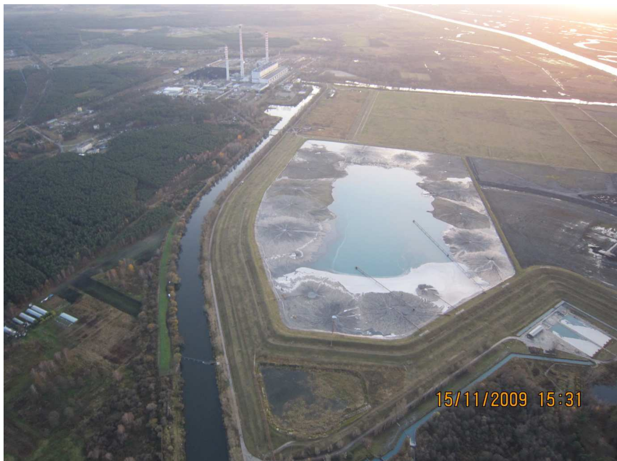
Zdjęcie 47. Kanał Ciepły przy Elektrowni Dolna Odra
