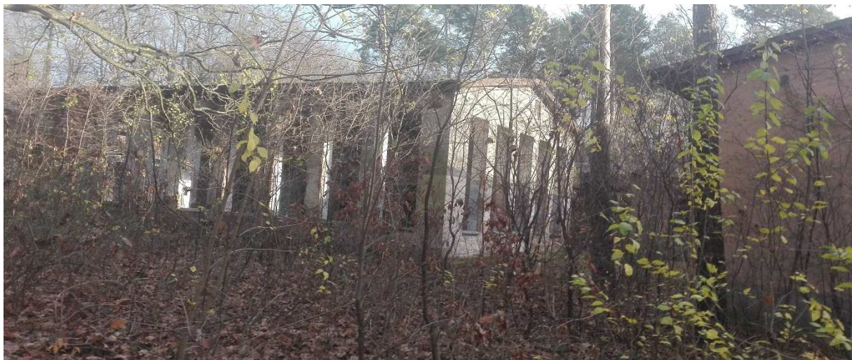
Zdjęcie 19. Opuszczone budynki po Sanatorium neuropsychiatrii dziecięcej, budynek basenu
